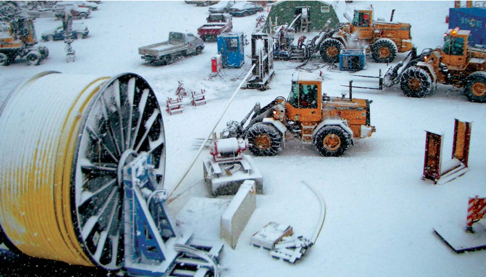
Fabrication de conduites - Projet Snøhvit en Norvège
