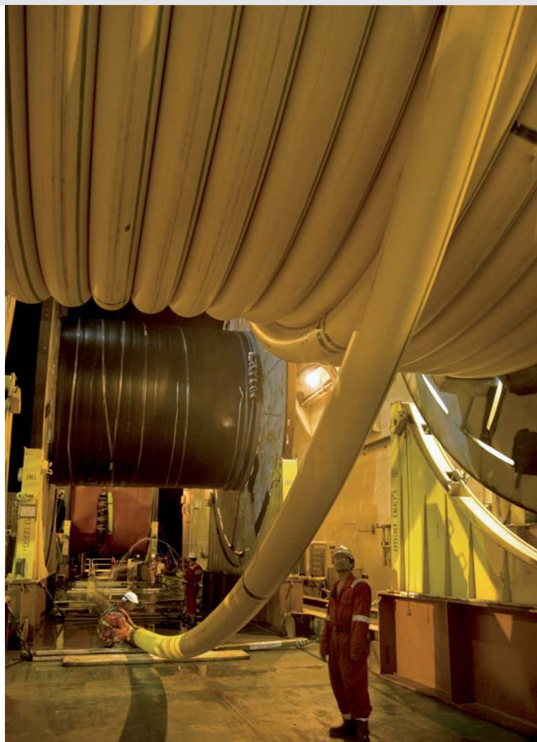
●●● Installation d'une ligne flexible sur le projet Agbami au Nigeria
