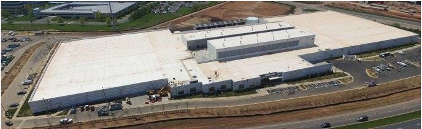
ACC9 Data Center Ashburn, VA
