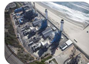
El Segundo Energy Center 2
